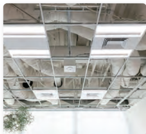
ダクトの増強工事を施し換気量を確保するとともに調湿機能も強化
